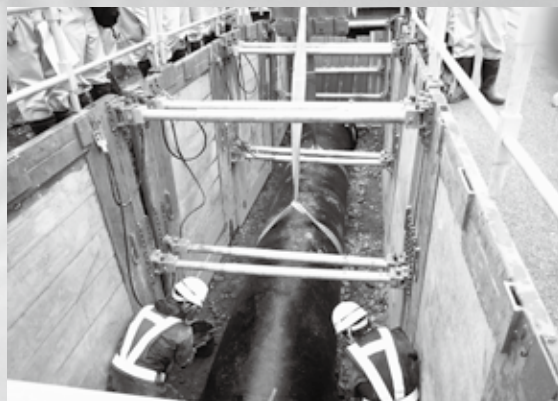
▲水道管路の耐震化の様子
